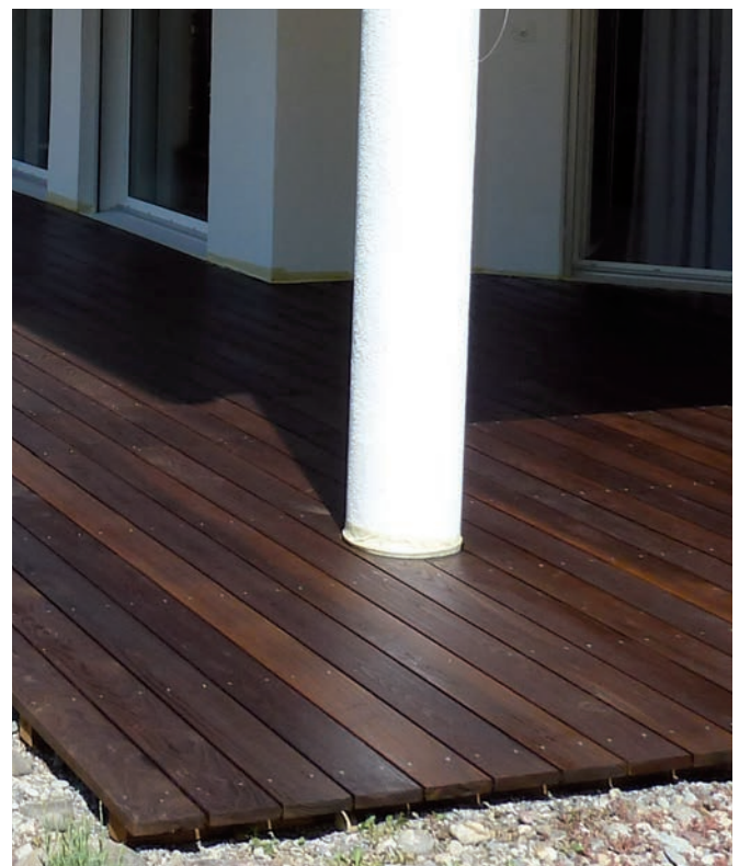
Nach der Verlegung wird eine Erstbehandlung mit einem geeigneten Öl aus unserem Sortiment empfohlen.
