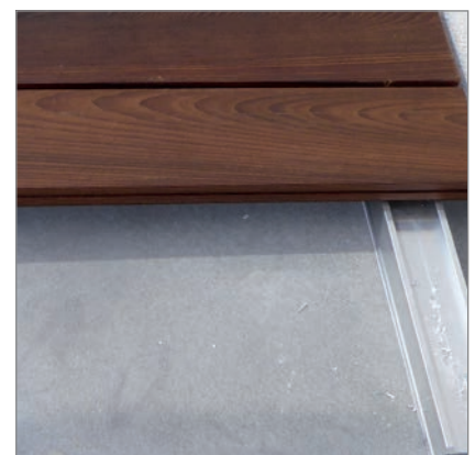
Wasserundurchlässiger Untergrund: ein Gefälle von mind. 1.5% ist zwingend.
