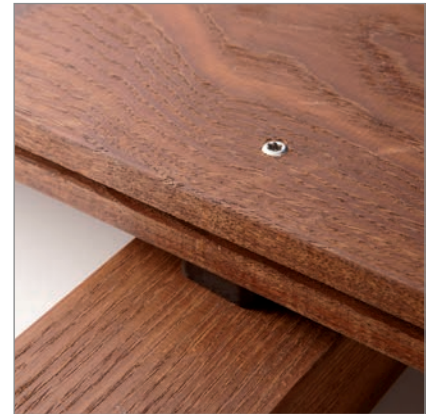
Die Unterkonstruktion Esche hat die gleichen Eigenschaften wie die Terrassendielen.
