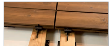
Die Längsstöße müssen auf zwei Unterkonstruktionshölzer liegen.
