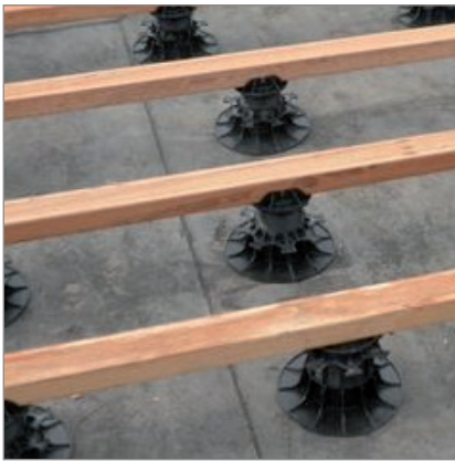
Dimension der Unterkonstruktionshölzer: 68 x 40 mm
