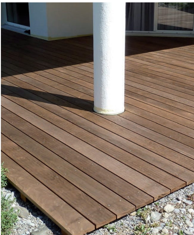
Frisch verlegte Terrasse
