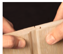
Nut-Feder-Paneel mit sichtbarer Feder
